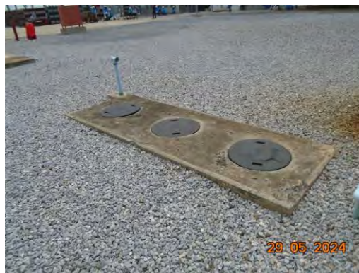
ภาพที่ 2-15 ถังบำบัดน้ำเสียจากการอุปโภค-บริโภค
