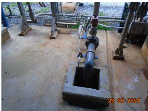
ภาพที่ 2-14 ถังปรับสภาพความเป็นกรด-ด่าง (Neutralization Tank)
