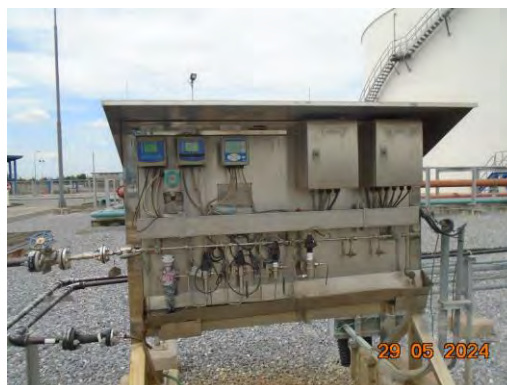
ภาพที่ 2-19 เครื่องตรวจวัดคุณภาพน้ำแบบอัตโนมัติ บริเวณบ่อพักน้ำทิ้ง
