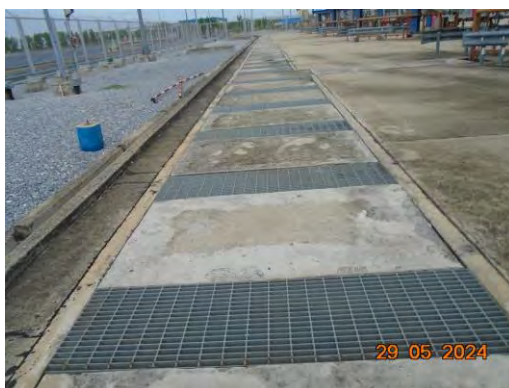
ภาพที่ 2-16 รางรวบรวมน้ำที่อาจปนเปื้อนน้ำมัน
