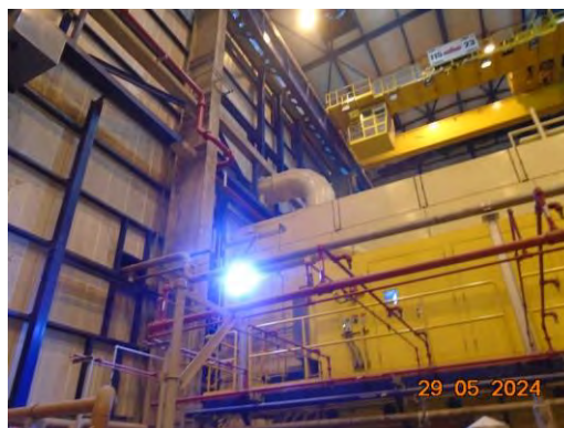
ภาพที่ 2-9 การติดตั้ง Acoustic Wall
